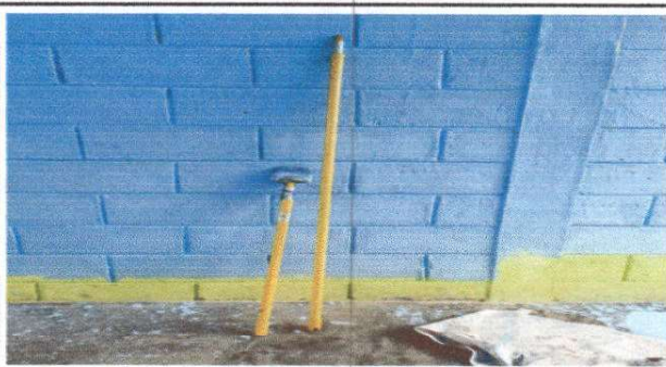
Foto 6: Mantenimiento a estructura (Pintura en muros exteriores e interiores)
