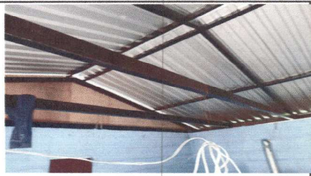
Foto 2: Sustitución de estructura de soporte de madera por madera
