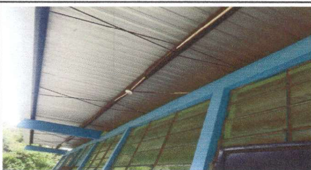
Foto 3: Reparación de sistema electrico
